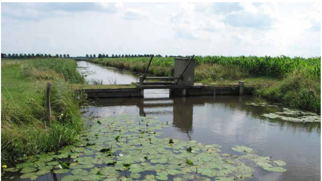
Een van de KRW-maatregelen is aanleg van vispassages om stuwen vispasseerbaar te maken.
